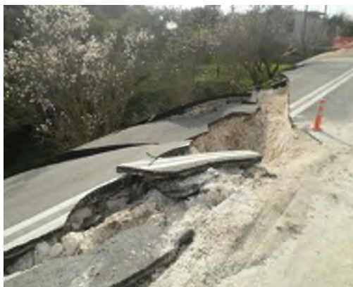
Фиг. 7.1.5 Повреди върху пътната мрежа между Ликсури и Хавриата (EPPO, 2014 г.)
