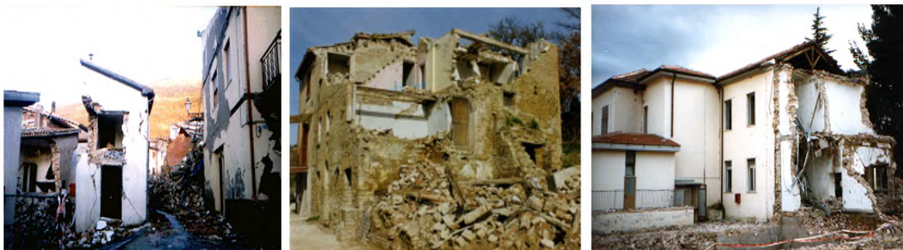
Фиг. 7.2.1 На фигурите по-горе може да се видят щетите, причинени от земетресението в Умбрия през 1997 г. Унищожено село (в ляво), срутени зидани сгради (изображенията в центъра и в дясно).
