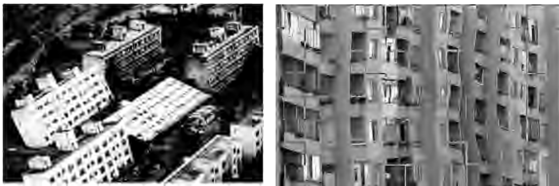
Фиг. 2.2.3.6 Разрушения след земетресение ( http://elearn.uni-sofia.bg/ )
