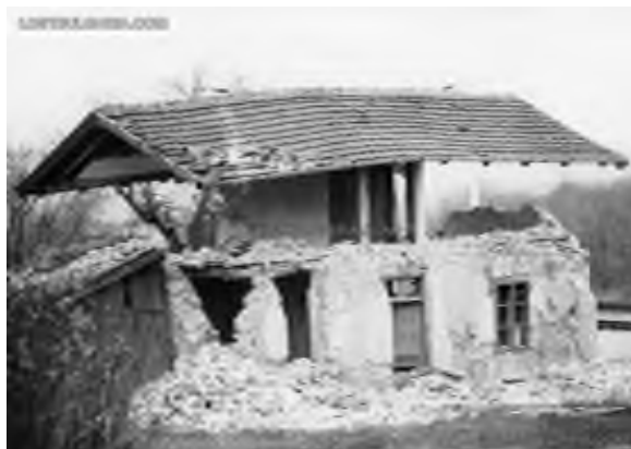
Фиг. 2.2.3.7 Разрушения след земетресение ( www.lostbulgaria.com )
