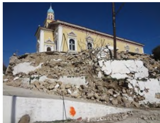
Фиг. 7.1.4 Повреди на подпорна каменна стена в село Хавриата (ЕРРО, 2014 г.)
