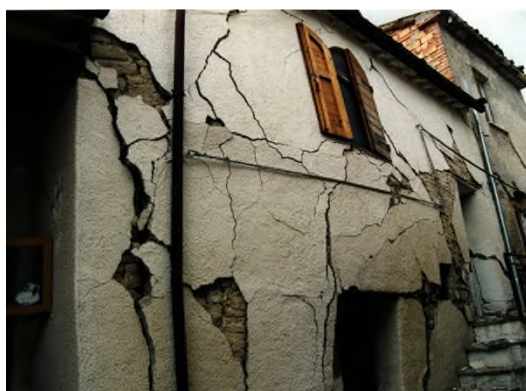
Фиг. 7.2.2 В тази зидана сграда е възможно да се види повреда, причинена от огъване на стена. Има добра връзка между покрива и стената, но подът на средния етаж не е свързан към стената.
