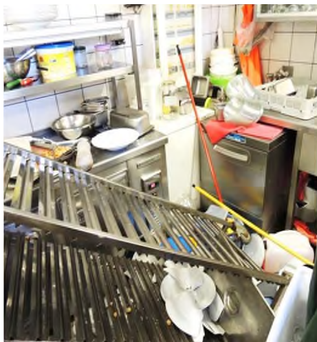
Фиг. 7.1.12 Неструктурни повреди: Липса на сеизмична защита на подвижните стелажи в ресторант, липса на ограничители на рафтовете и лошо закрепване за тавана на плочки и осветителни тела (GEER / EERI / ATC).
