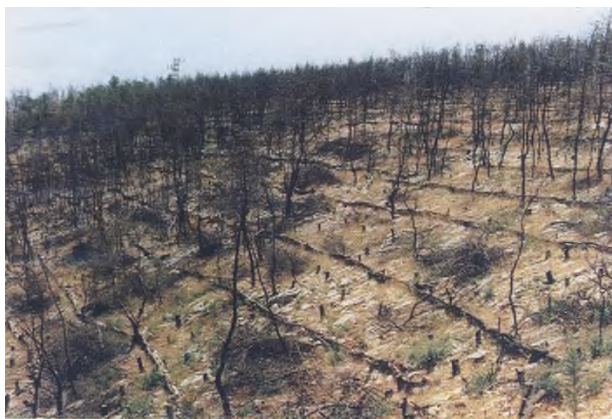
Фиг. 6.9 Прегради от трупи по топографските контури, изградени в рамките на 3 месеца след пожара на 21 юли 1995 на склона Агиос Петрос над град Неа Макри в планината Пентели, източно от Атина (Г. Ксантопулос)
