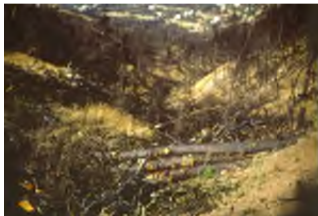
Фиг. 6.10 Язовир изграден от трупи в дерето на планината Пентели в рамките на 3 месеца след пожара от 1995 г. (Г. Ксантопулос)
